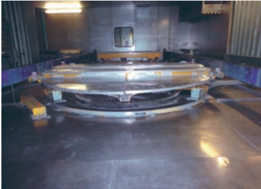
Montage eines Kettenförderer, Dreh- und Exzenterhubtisches für Fa. DÜRR Systems bei Mercedes-Benz, Rastatt
