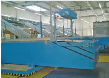
Prüfung & Inspektion von Teleskopförderern bei Fa. Bruno Bader GmbH + Co. KG
