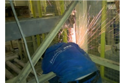
Modernisierung einer Absackanlage bei MC - Bauchemie Müller GmbH & Co. KG
